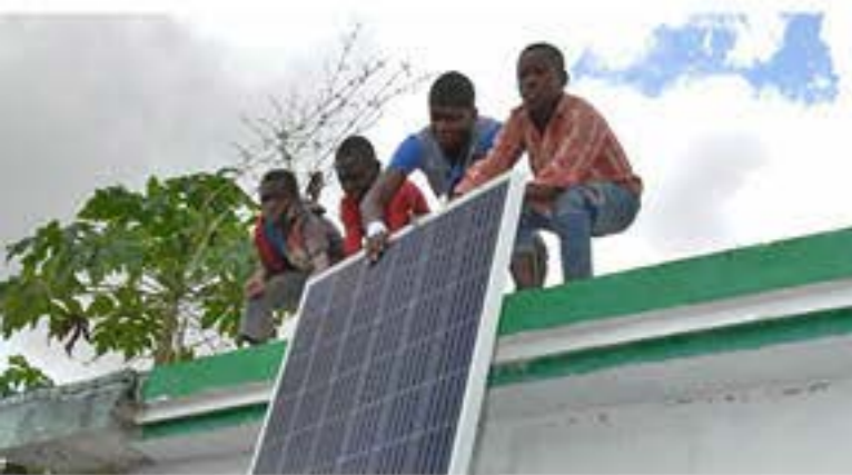
Solaranlage wird installiert - Strom für den Gesundheitsposten von Medi-Pharma
