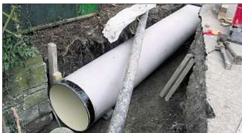
Sanierung für den Butzenbach: Die Arbeiten sind derzeit im Gang. (gs)
